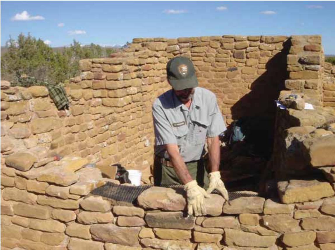
**Figure 24. Geonet Installation (Matero 2008)**
